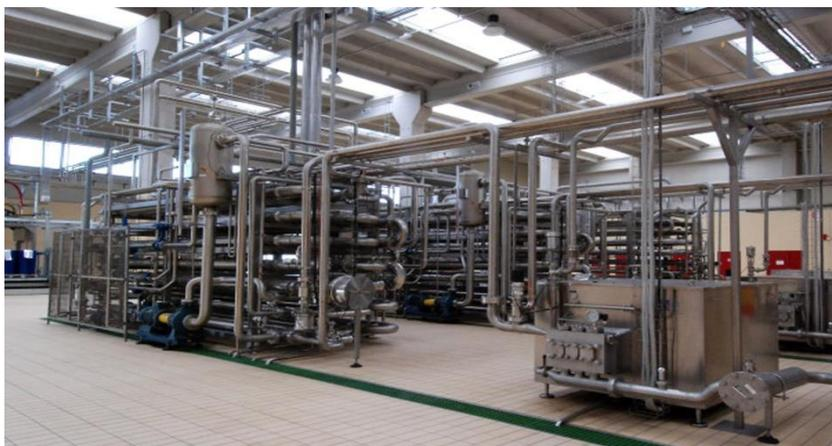
Стерилизация и охлаждение продуктов, не являющихся экстремально вязкими, производится в системе Olympus, использующей принцип «труба в трубе» и воду из градирни. Для стерилизации высоковязких продуктов (например для производства томатной пасты «Super-Hot Break») применяется система Flash Cooler.
